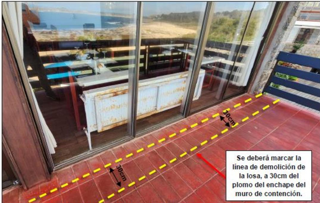
Figura 7: Vista superior del plomo de demolición a demarcar sobre la losa.
