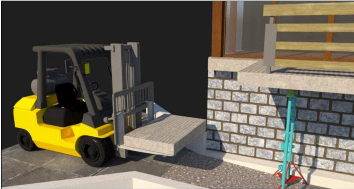
Figura 24: Retiro de franja de losa demolida mediante el uso de grúa horquilla.
