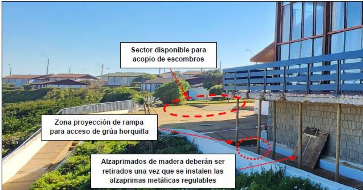
Figura 11: Zona de proyección de rampa, alzaprimas existentes y sector para acopio de escombros.
