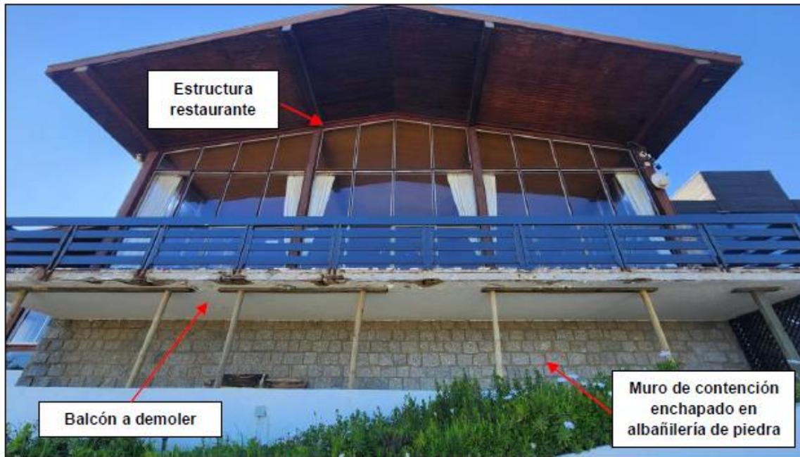
Figura 2: Vista frontal exterior del balcón a demoler.
