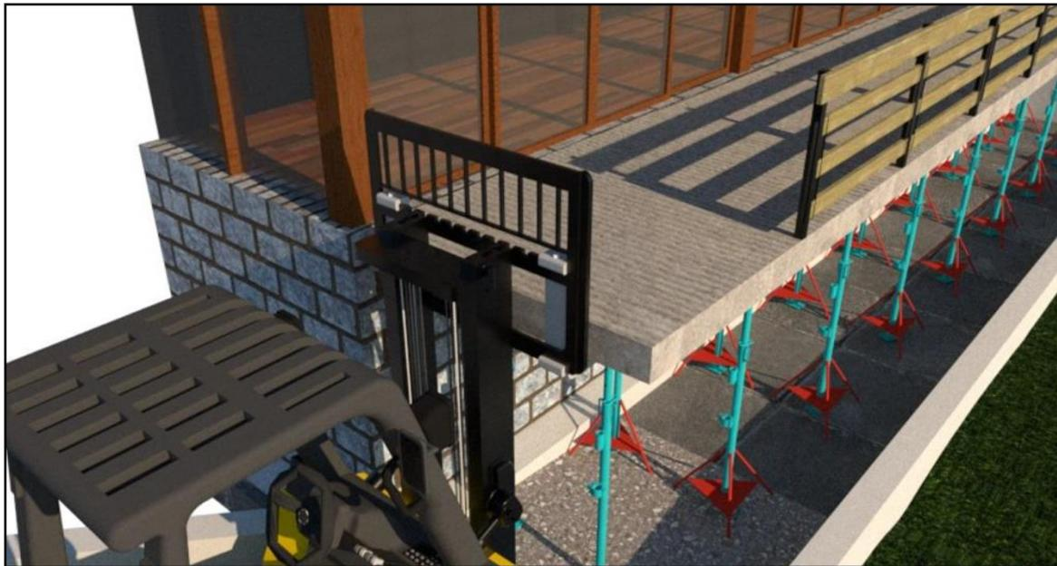
Figura 21: Posicionamiento de la grúa horquilla, sosteniendo losa, previo al comienzo de la demolición.
