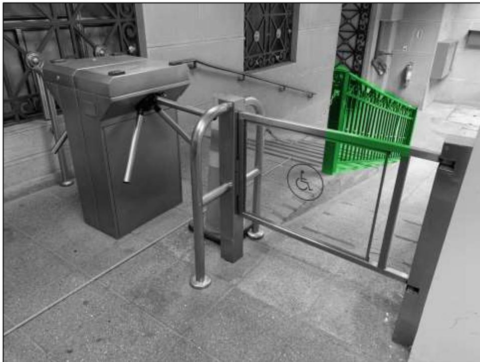
Imagen N°1: Retiro de Baranda Metálica Rampa Acceso Morandé
